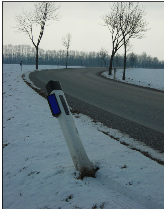
Abb. 20: Von Kfz angefahrener Leitpflock mit optischem Swareflex-blau-Reflektor. Foto: W. Steiner
