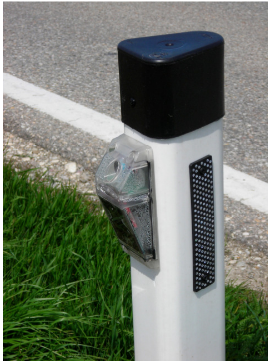
Abb. 18: Fehlerhafte Montage eines akustischen Wiwasol II Gerätes. Foto: W. Steiner
